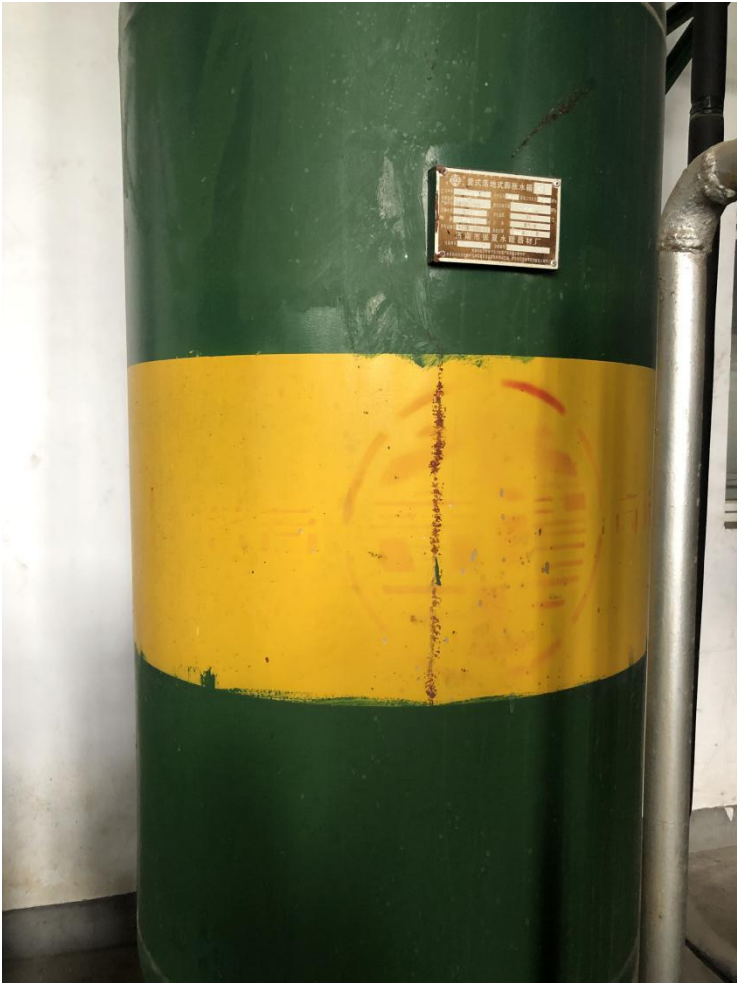
囊式落地式膨胀水箱
